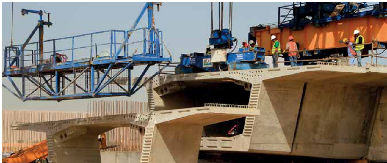
Viaducto Wadi Hanifa, Riyadh (Arabia Saudí)
