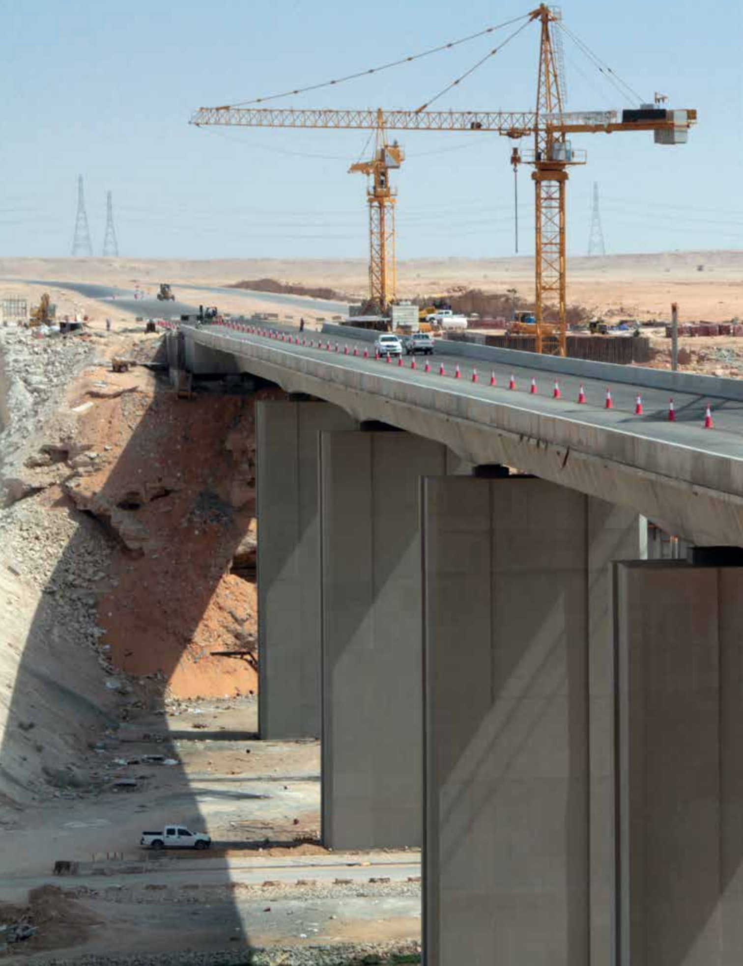
Viaducto Wadi Hanifa, Riyadh (Arabia Saudí)
