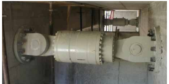
Autopista A24 L'Aquila Teramo Cantiere Pizzoli (Italia)
